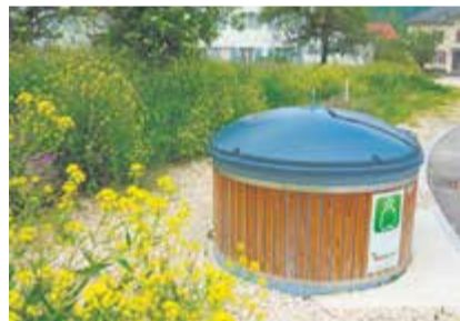
La situation devrait s'améliorer très généralement dans le domaine des déchets, notamment avec l'utilisation des conteneurs semi-enterrés depuis août 2023
