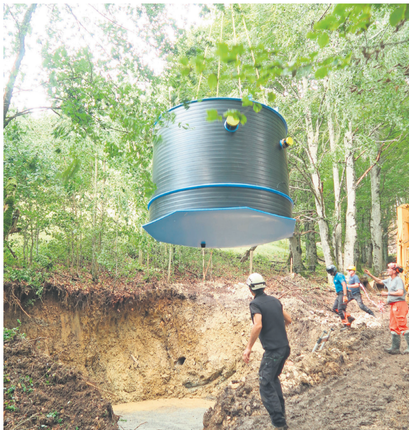
L'hélicoptère a posé délicatement et précisément ce « monstre » de deux tonnes et demie
